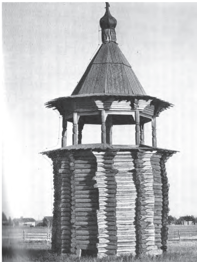
Рис. 2. Звонница в с. Цивозеро с боковыми искривлениями вверх двух угловых соединений (справа) (Ополовников, 1977).
