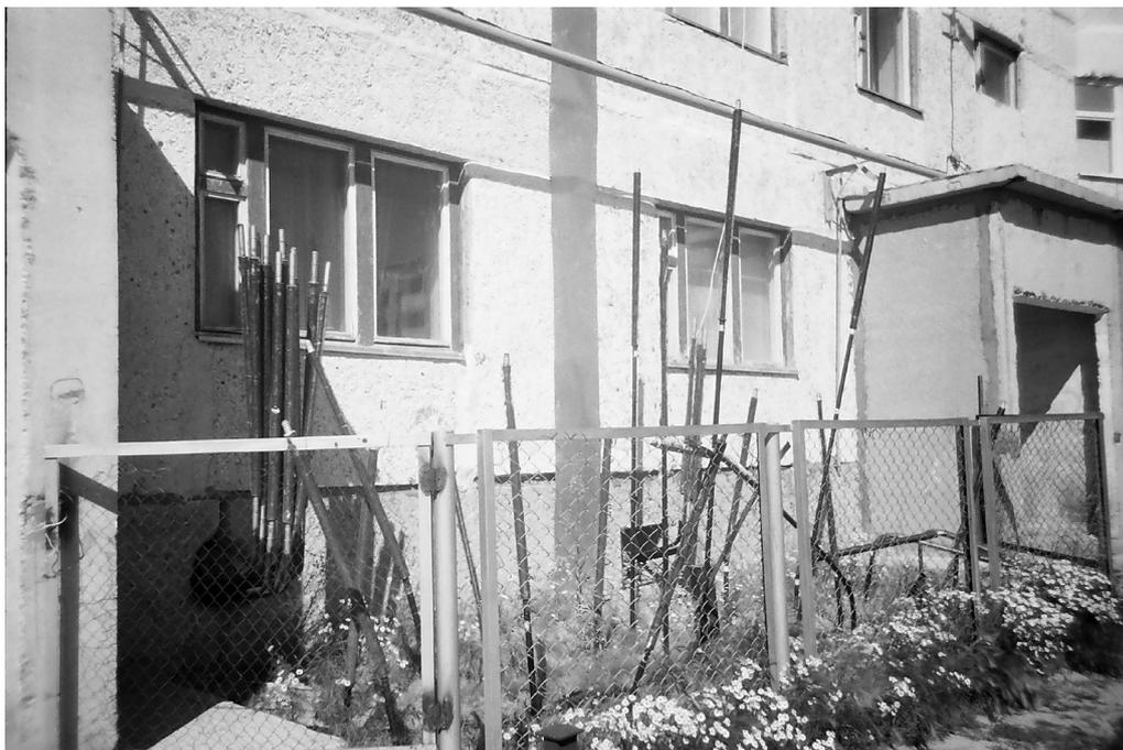
**Рис. 5.** Использование метода технической мелиорации – замораживание основания зданий с помощью термостабилизаторов (г. Надым, ул. Топчева, 9).
